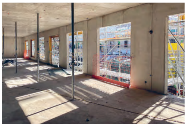
Der zukünftige Speisesaal im Lighthouse wird dank vielen Fenstern einen tollen Blick auf den Garten bieten.
