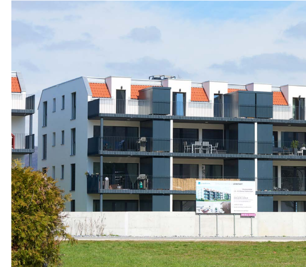
Leibstadt AG: Die von Crowdhouse vermittelte und verwaltete Siedlung Prato Verde neben dem Atomkraftwerk Leibstadt
